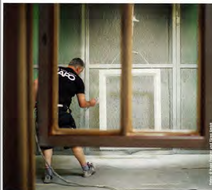
Blick in die Holzfensterbeschichtung im Kapo-Werk Pöllau. Für einen nachhaltigen Holzschutz nutzt das Unternehmen die wasserbasierte und hydrophobierende Imprägnierung Induline IW-130 von Remmers.
